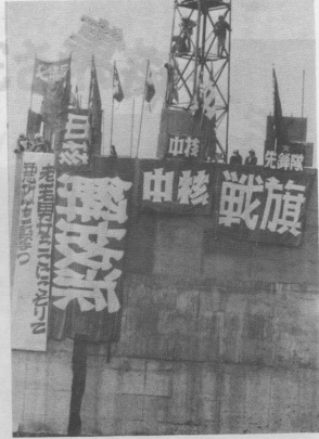
▲3月26日機場裏面に再び鉄塔が立つ
